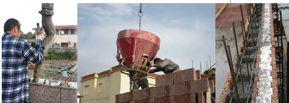
3 ■ riempimento in calcestruzzo con pompa a secchione
