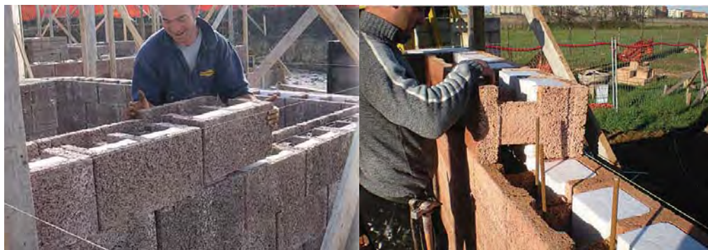
1 ■ posa in opera a secco dei blocchi
