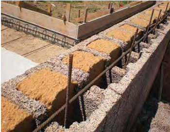
■ Esempio di posa in opera di un BLOCCO DA 38 cm. in legno-cemento con isolamento ecologico ad inserimento in FIBRA DI LEGNO (super ecologico e super performante)
