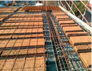
■ Esempio di posa in opera di un SOLAIO SOLAFON con isolamento ecologico a pignatta in SUGHERO (super ecologico e super performante)
