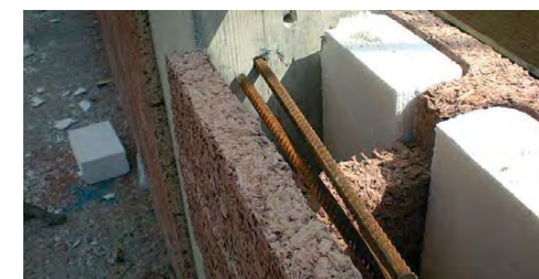
■ Parete collegata, con ferri, alla struttura.
