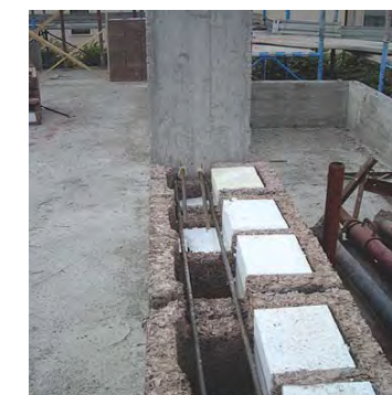
■ Parete collegata, con ferri, alla struttura.
